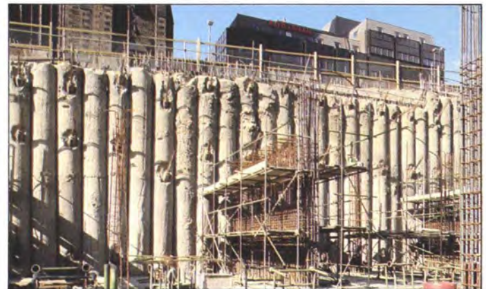
Secant pile wall
