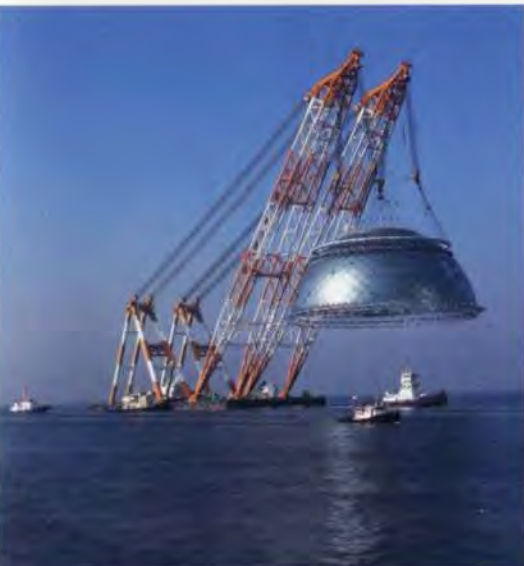
(d) The dome lifted from the barge.
