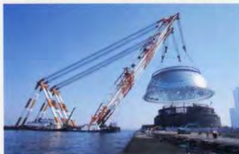
(d) The dome lifted from the barge.
