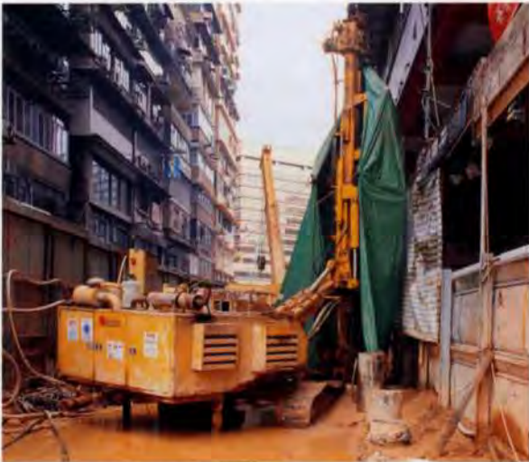
11. Mini pipe piling rig in Mody Road.
